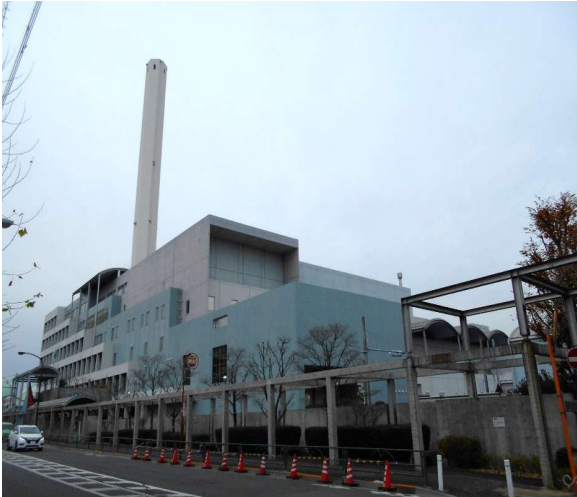
【工場全景写真】
