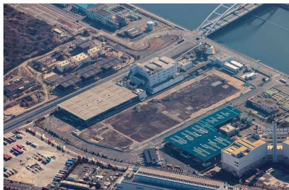
【工事状況写真】(令和7年3月)
