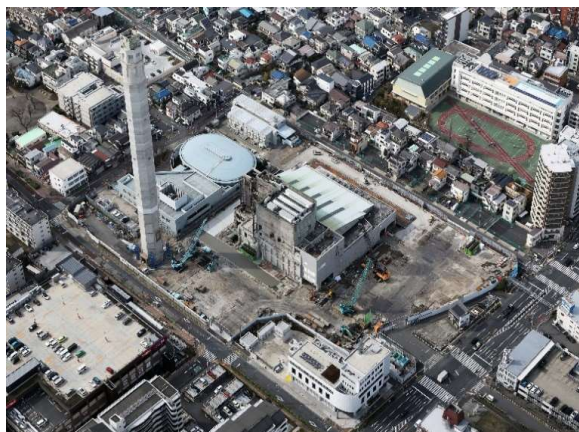
【工事状況写真】(令和7年3月)
