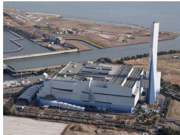
【工場全景写真】
