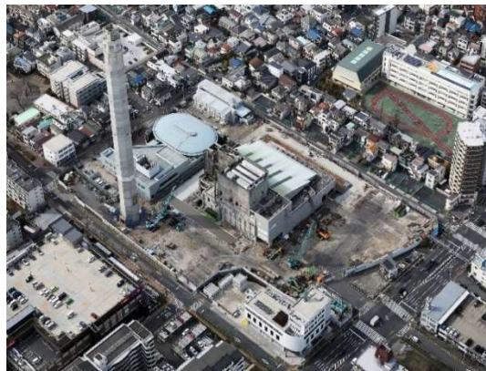
【建替工事（北清掃工場）】
