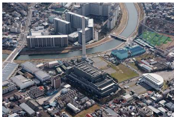
【工場全景写真】
