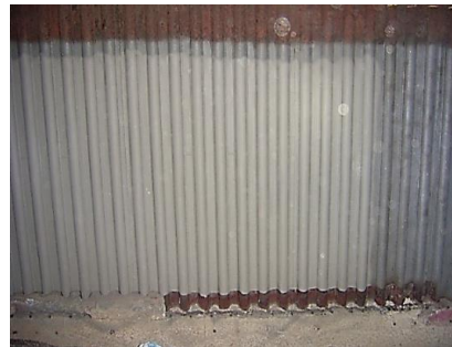
【整備後のボイラ水管】
