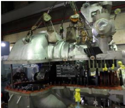
【蒸気タービンの開放点検(発電設備)】
