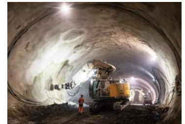
トンネル工事(コンクリート吹付)
